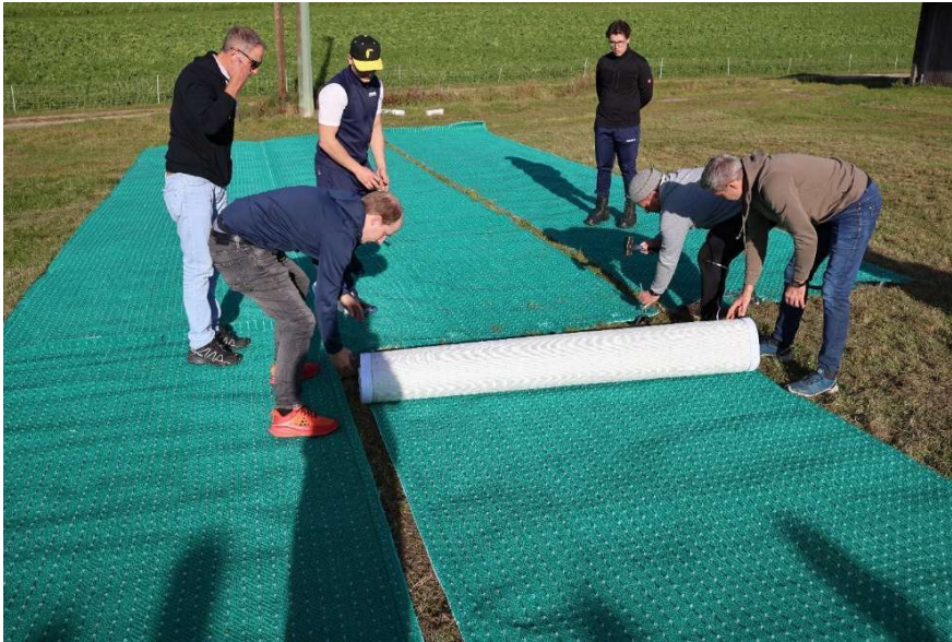
Ausrichtung der weiteren Matten. Wieder an der äußersten Matte orientieren.
